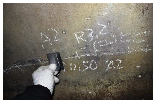
側壁の水平方向ひびわれ (遊離石灰を伴う)
