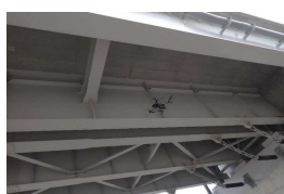
ドローンによる桁下の点検
