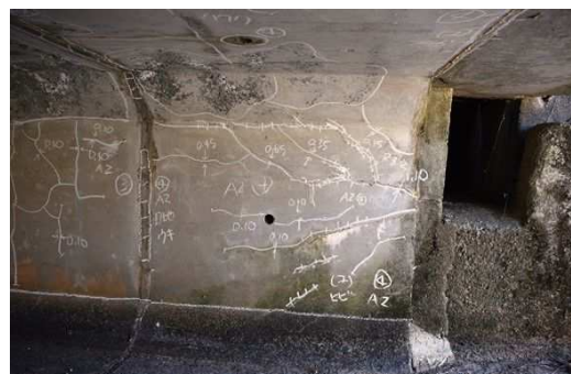
側壁の遊離石灰 (錆汁混入) を伴うひびわれ
