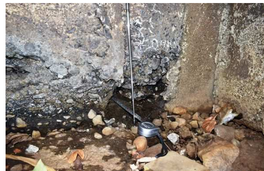
下部工前面の欠損
