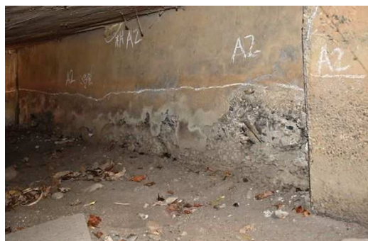
下部工前面の欠損
