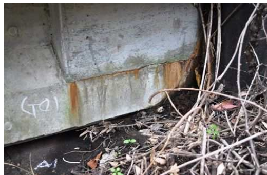
端横桁PC定着部の遊離石灰 (錆汁伴う)
