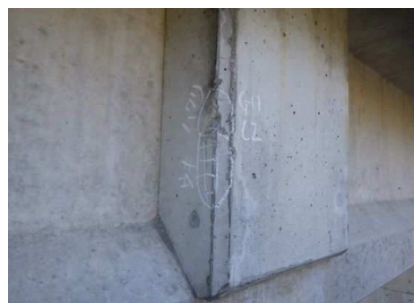
中間横桁PC定着部の剥離、うき
