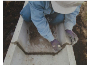
3. 用排水路復旧
