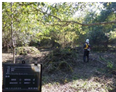
除草・支障木処理
