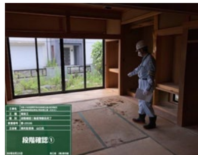
屋内の整理・解体
