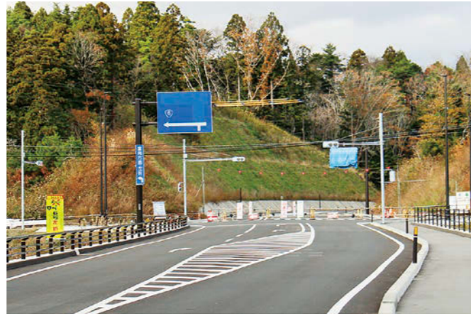
檜葉町の井出地区まで開通した県道広野小高線(通称・浜街道)。信号から先が工事中の波倉～富岡工区、信号を右折で東京電力福島第二原子力発電所、左折で町内太田方面～国道6号
