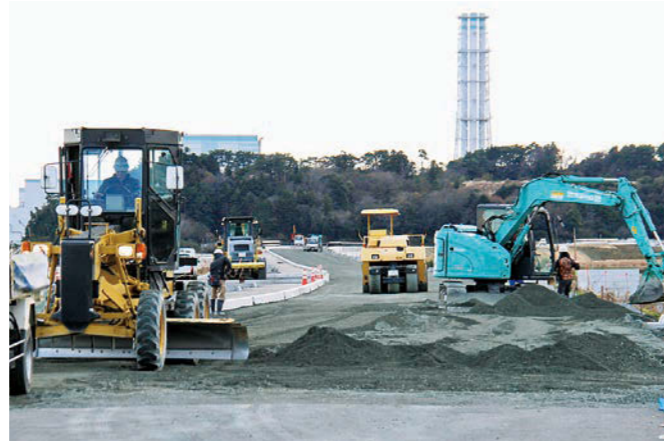
浜街道の整備工事が続く仏浜～毛萱地区
