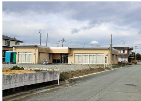
解体が決まった新田多目的集会所
