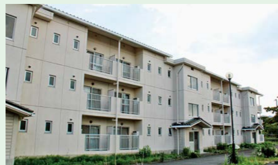
新田住宅(現況)
