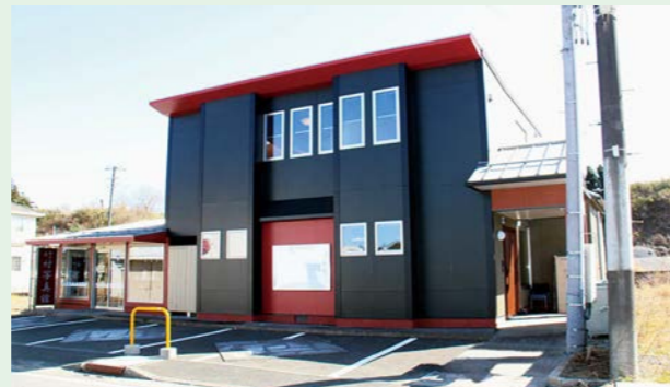
お試し住宅(旧竹村写真館)
