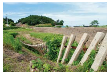
津波で捻じ曲げられた軌きょう (2016年毛萱地区)
