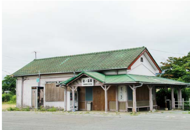
完成した待合室(上)と旧夜ノ森駅舎
