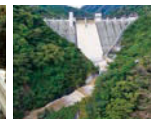
越水中の滝川ダム
