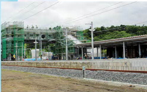
完成が近づく新しい駅舎と跨線橋(2017.8.2 撮影)
