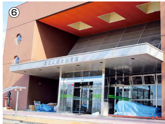
総合体育館の復旧工事。平成29年3月末に完成予定です。
