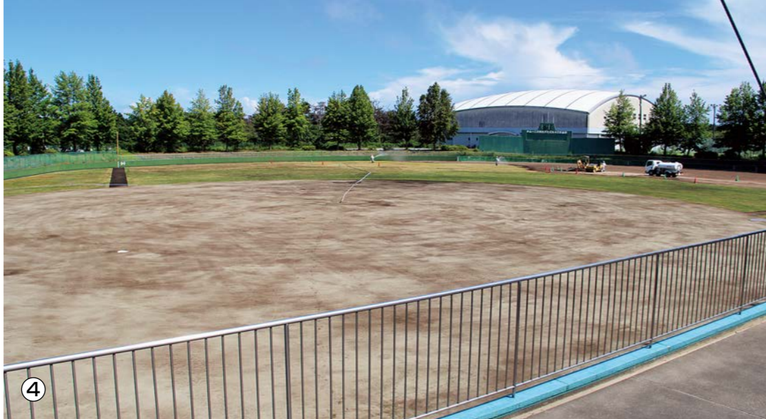
↑ 除染が完了し、現状復旧のため芝を貼る作業が行われています。
