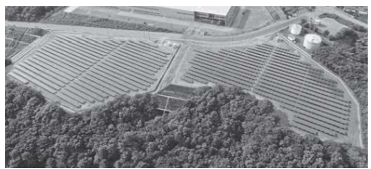
3.1ヘクタールの敷地にソーラーパネル約8600枚を設置
