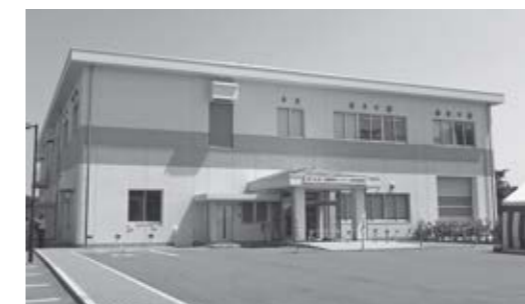
完成した双葉環境センターし尿処理施設
