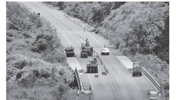
復旧が進む常磐自動車道
