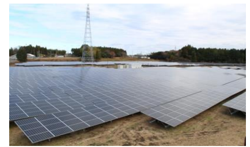
増加する太陽光発電設備
